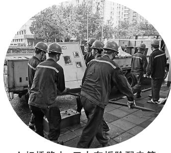
▲虹桥路上,工人在拆除配电箱
