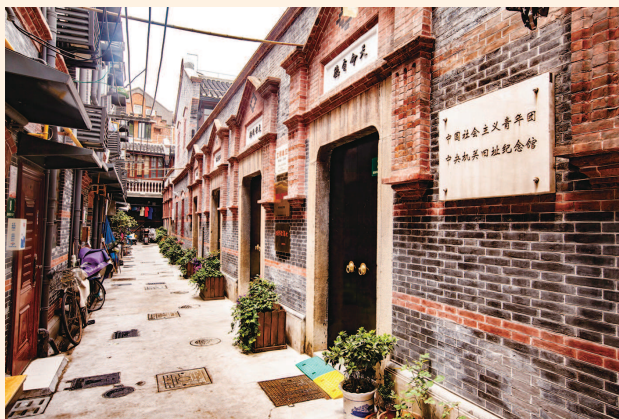
中国社会主义青年团中央机关旧址，淮海中路567弄6号（原霞飞路新渔阳里6号），坐北朝南，为两层楼砖木结构石库门建筑
