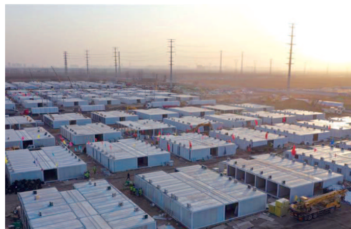
河北石家庄黄庄公寓隔离场所正在紧张施工
