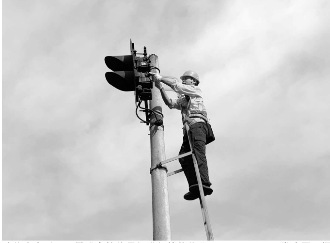
骆俊杰在烈日下攀登高柱信号机进行检修作业
