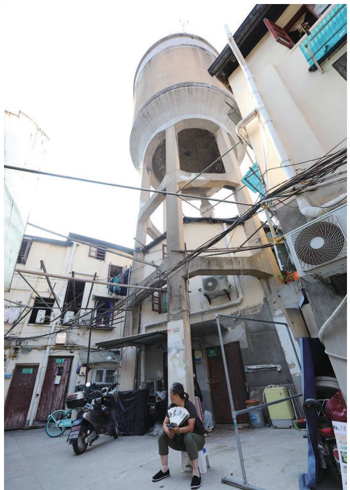
建国东路143弄，独一无二的“水塔楼”
