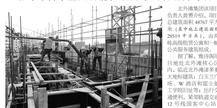
昨天，“北外滩77街坊高品质租赁公寓”（雅诗阁项目）1号楼主体建筑23层最后一块顶板混凝土浇筑完成 见习记者 沈媛 摄
