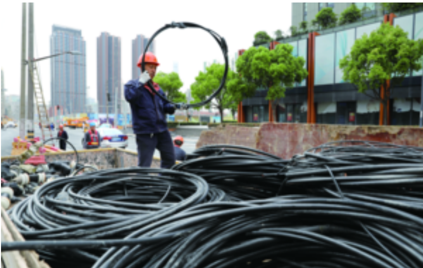
昨天下午，天潼路曲阜路路口，电力职工正在拆除路口的架空电缆线
