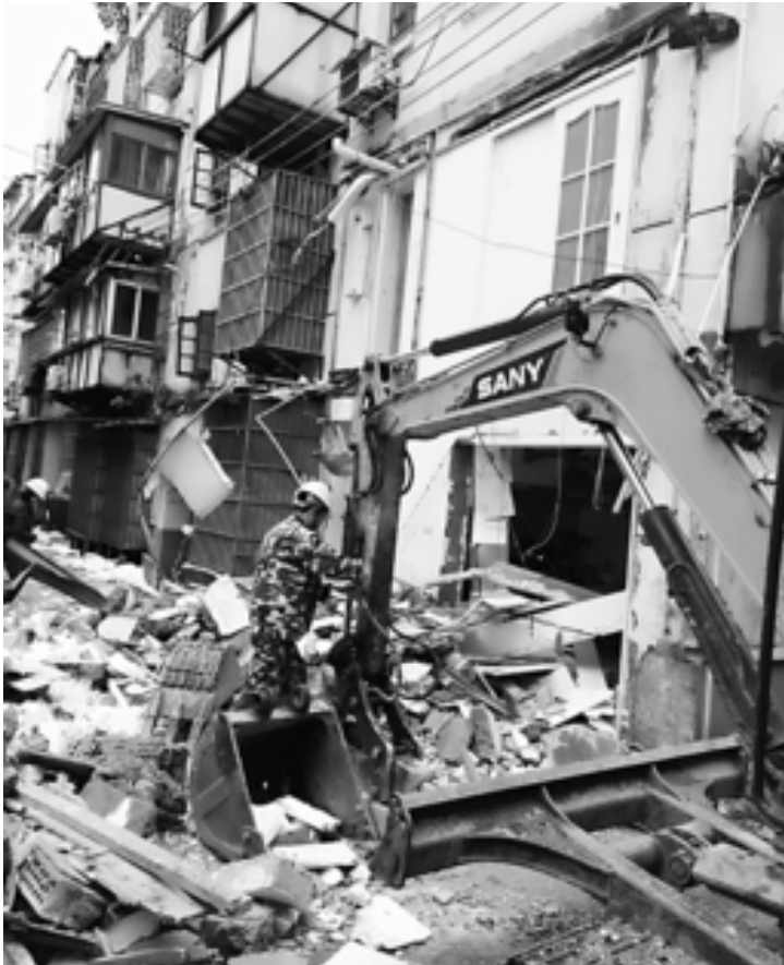
大连西路201弄17号吊脚楼拆除后 资料图片
