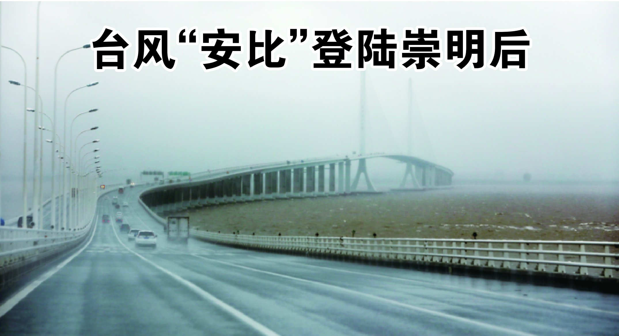
因台风“安比”过境而临时封闭的崇明长江大桥，昨天 14 时 15 分陆续恢复通行
