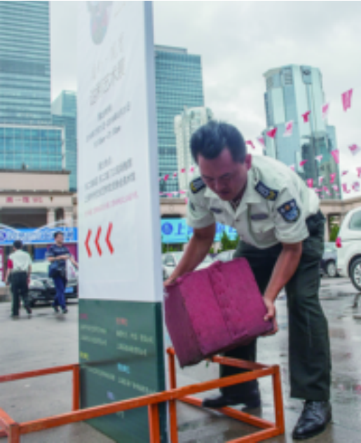
上海书展工作人员对户外广告牌进行加固
