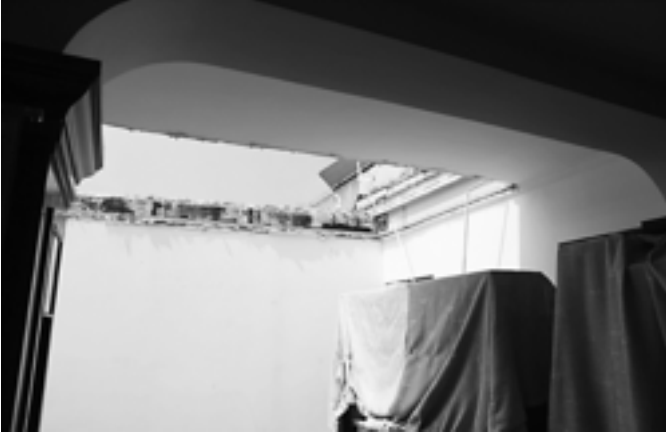
违法搭建的露台恢复原样
