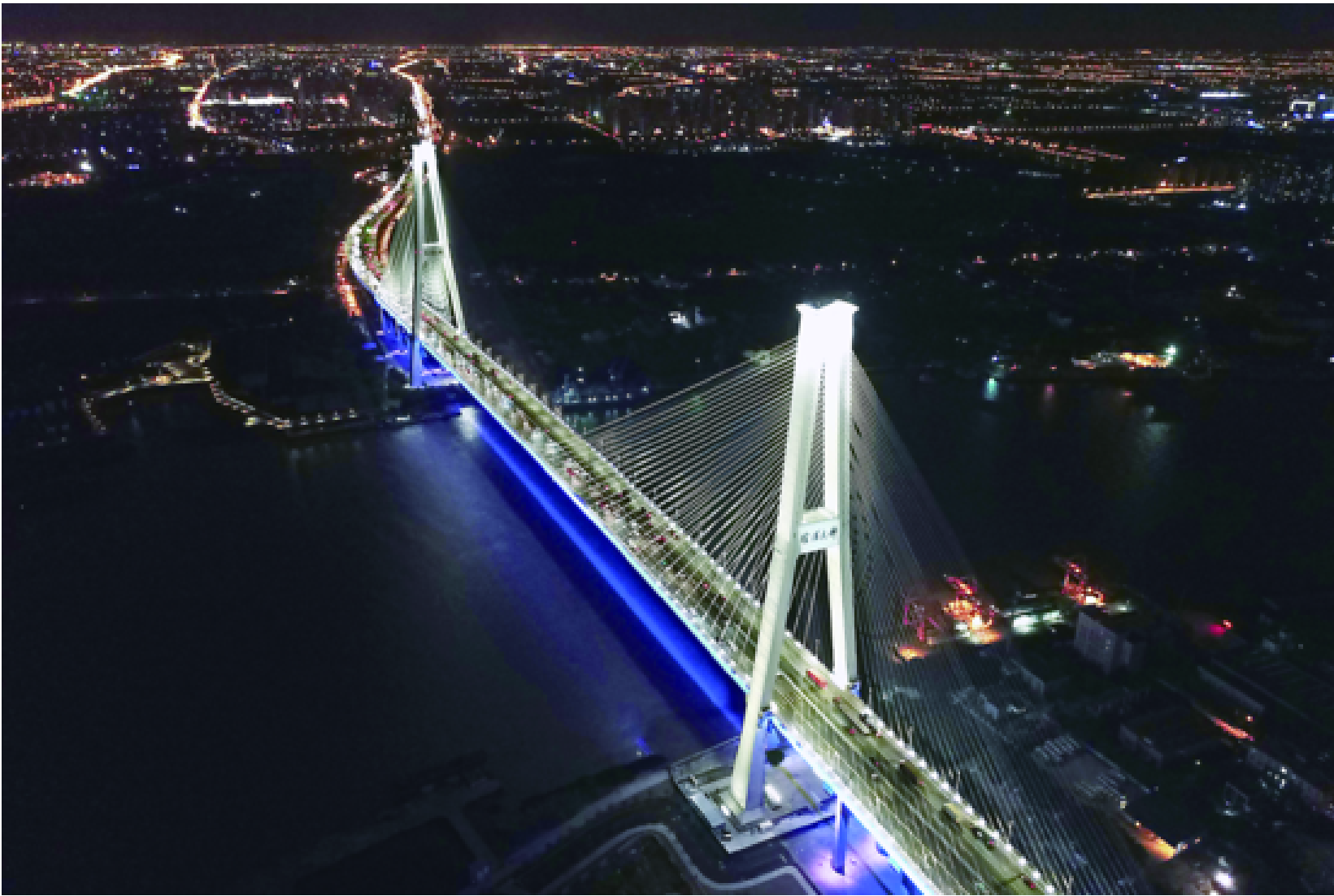
徐浦大桥景观灯工程改造接近尾声
