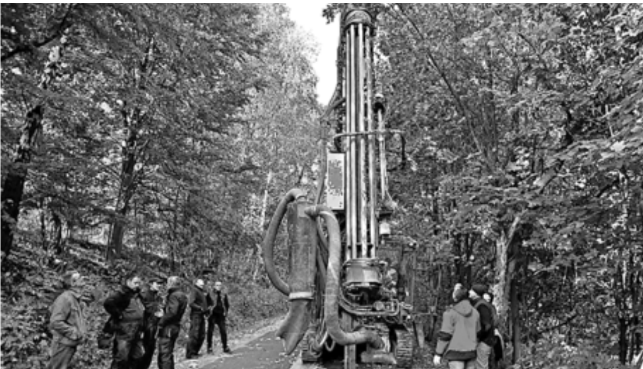
2015 年 10 月，波兰地方政府雇用一个团队对斯帕科斯基声称有纳粹地下通道的地方进行钻孔勘测
