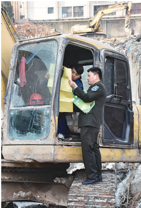
重庆交通执法人员到静安区和田路一处川渝老乡集中的工地送“避堵地图”
