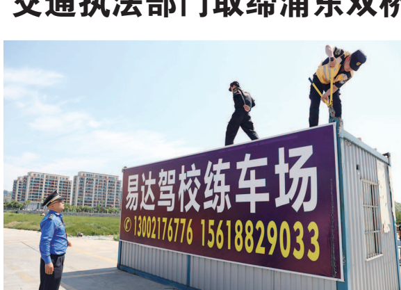
执法人员现场拆除广告牌
