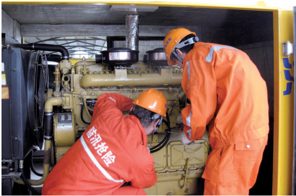
台风来袭前上海城投对防汛应急抢险设备进行再检查和维护保养
