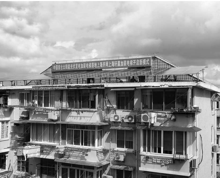
39号楼顶上成片的光伏电板（前图）上海首台太阳能光伏发电加装电梯昨在曹杨街道桂巷新村启用（后图）
