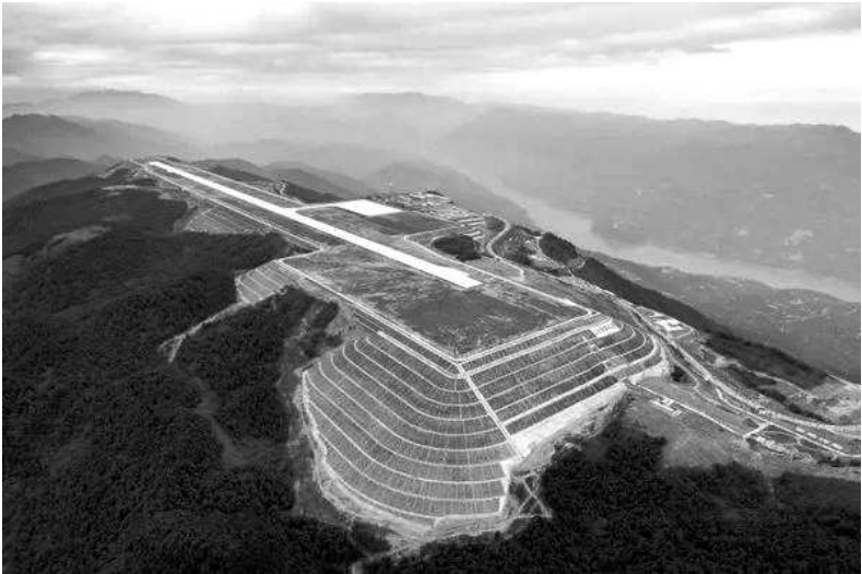
巫山机场是目前重庆海拔最高的民用机场 中国民航网 图
