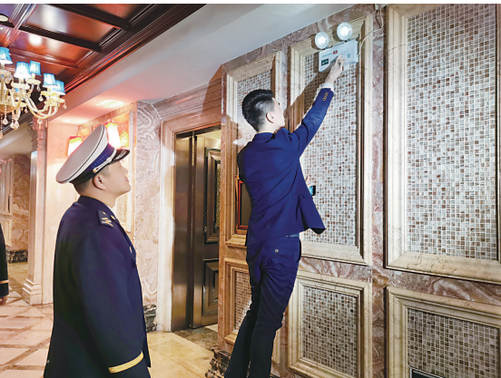
24日晚，金山区消防救援支队消防人员检查沪杭公路上一家KTV娱乐场所应急照明灯使用状况
