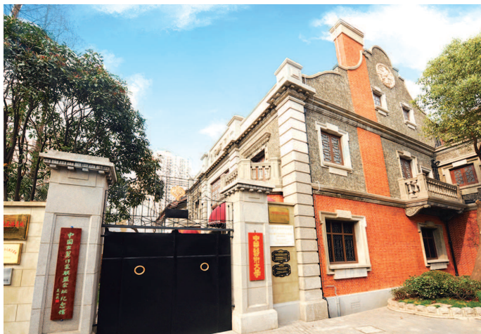
左联会址纪念馆修缮后重新开馆
