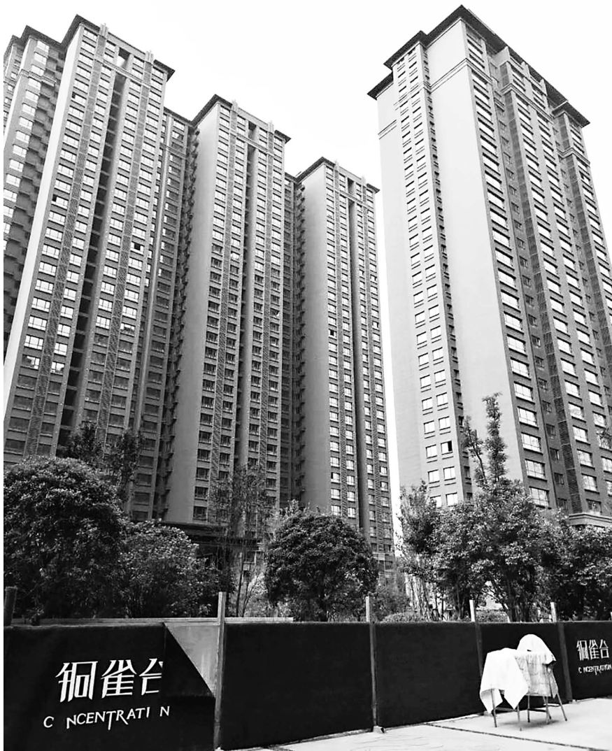
铜雀台小区 2 号楼（前）已封顶
