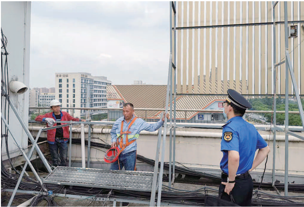
在“黑格比”到来前，徐汇区华泾镇城管中队拆除了楼顶存在安全隐患的广告牌
