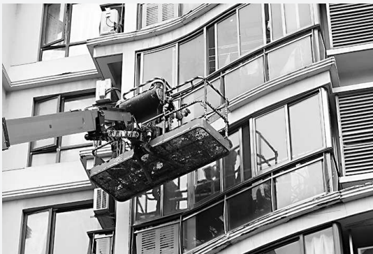
目前该小区部分楼栋正在施工修缮
