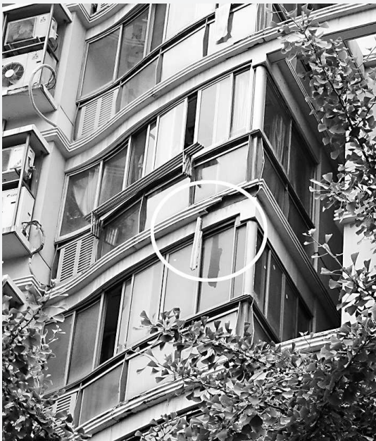
广灵四路某小区多幢住宅建筑外墙装饰性结构出现掉落安全隐患
