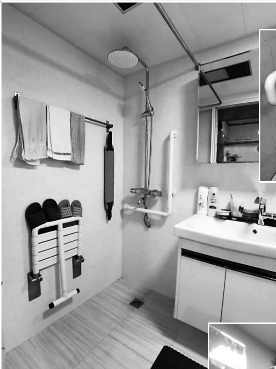
图为石库门改造后的淋浴空间，助浴凳在墙上折叠，扶手安装到位，地面经过防滑处理
