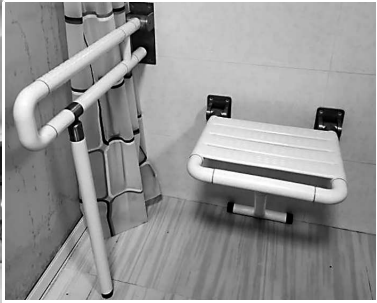
图为石库门改造后的淋浴空间，助浴凳在墙上折叠，扶手安装到位，地面经过防滑处理
