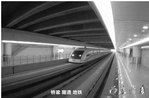
桥梁 隧道 地铁
