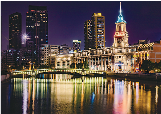
四川路桥，又名“里摆渡桥”，1922 年改建为三孔钢筋混凝土悬臂梁结构
