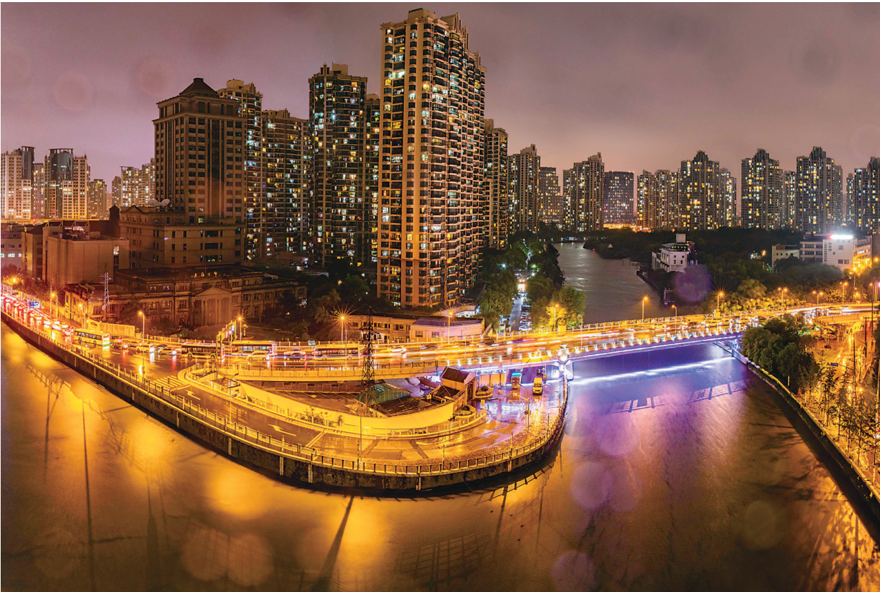
江宁路桥，又名“造币厂桥”，于 1929 年建成，1949 年、1968 年、2012 年多次重建
