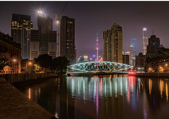
浙江路桥，1880 年修建，是我国现在仅存的几座鱼腹式简支梁钢桁架的老桥之一
