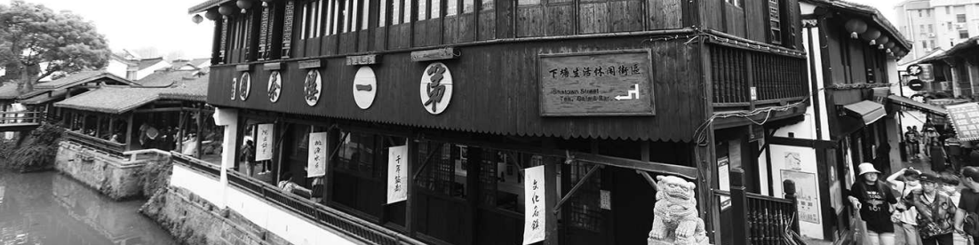
◀ 新场古镇第一楼茶园（洪福饭店旧址）
