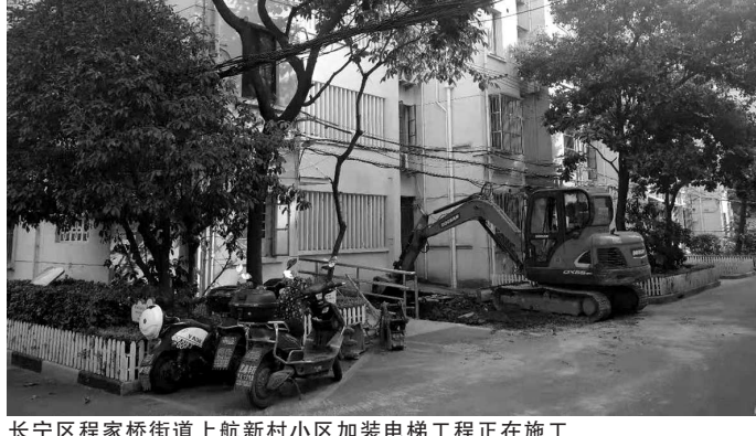
长宁区程家桥街道上航新村小区加装电梯工程正在施工
