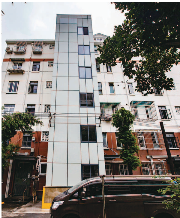
已投入使用的电梯
