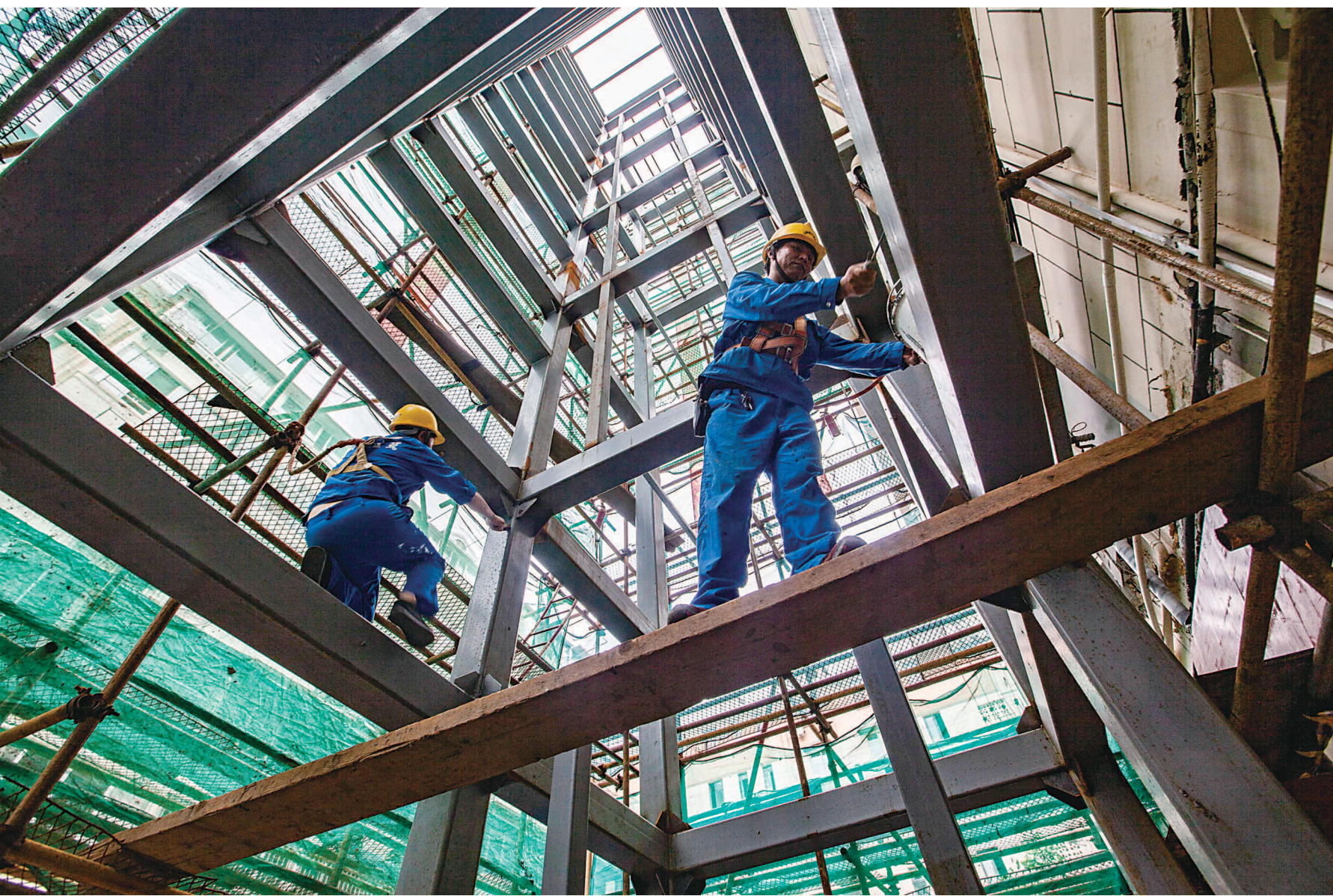
加装电梯施工现场
