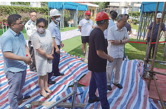
市人大代表唐曙建视察校舍修缮情况
