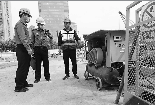
城管队员来到长宁区娄山关路一处被投诉噪音扰民的工地检查
