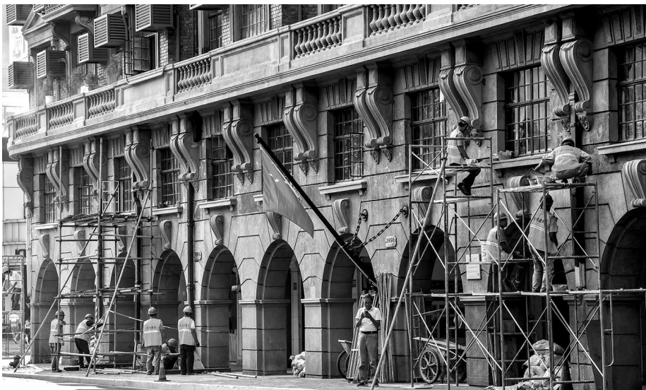
武康大楼，水刷石修补完后进行采用“平色”工艺确保整体协调
