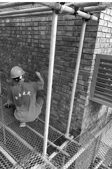
武康大楼，采用专用工具，进行清水砖墙勾缝
