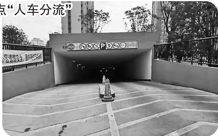
惠南镇民乐城建欣苑小区（南苑）的“人车分流”设施
