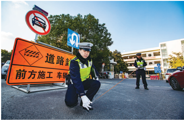
对复杂路幅进行测量
