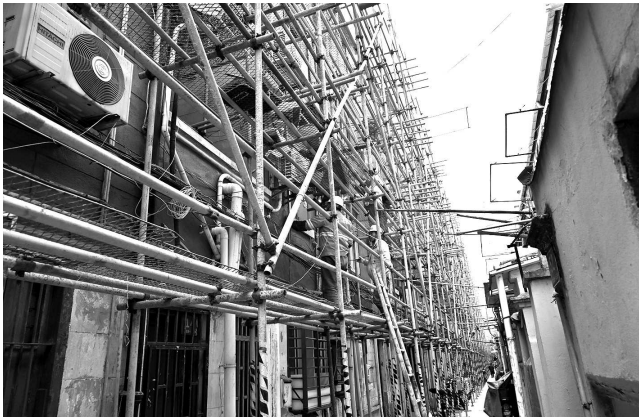
永安里建筑已搭起脚手架
