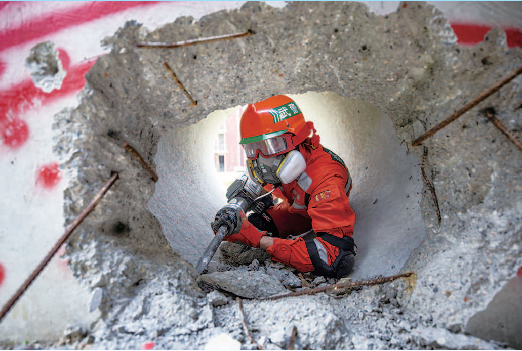
官兵在模拟地下管道开展狭小空间破拆训练
