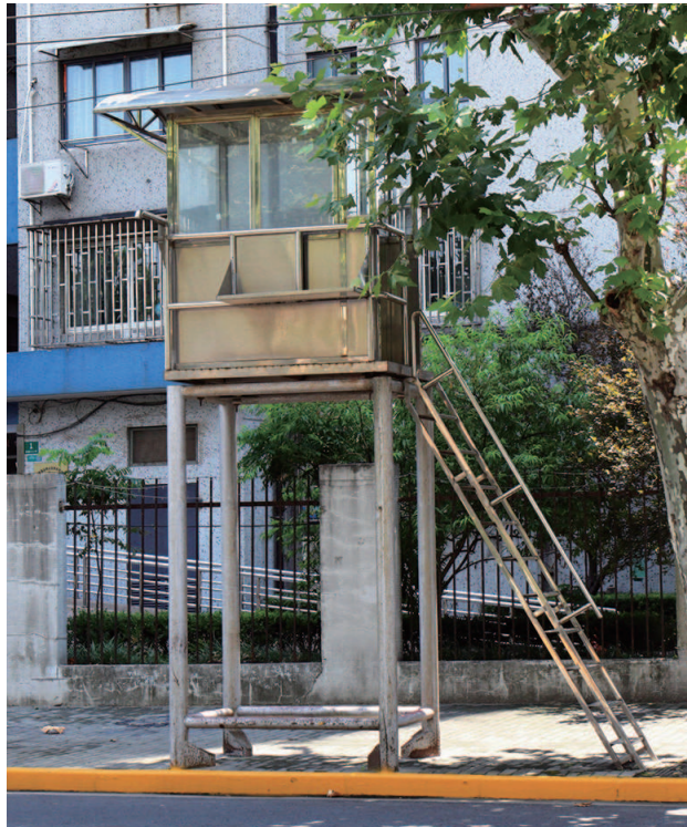
司机每天靠这个高亭检查“辫子”顶端采电设施是否正常
