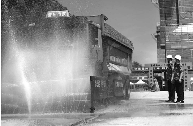
奉贤区一工地，城管队员对渣土运输进行现场管理 记者 王湧 摄
