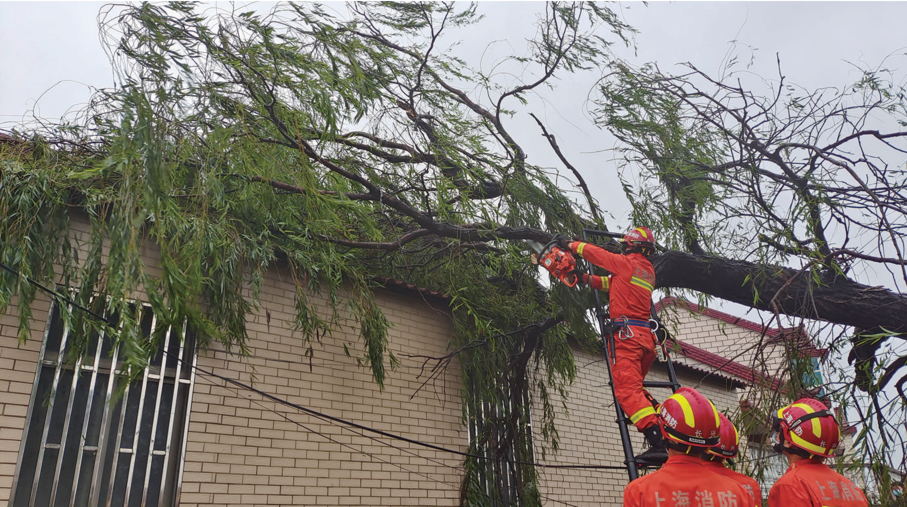
2022 年 9 月 15 日 5 点 56 分，长兴镇创建村一村民家房屋被路旁倒伏树木压住，情况危急。崇明消防接警，立即组织应急抢险力量赶赴现场处置
