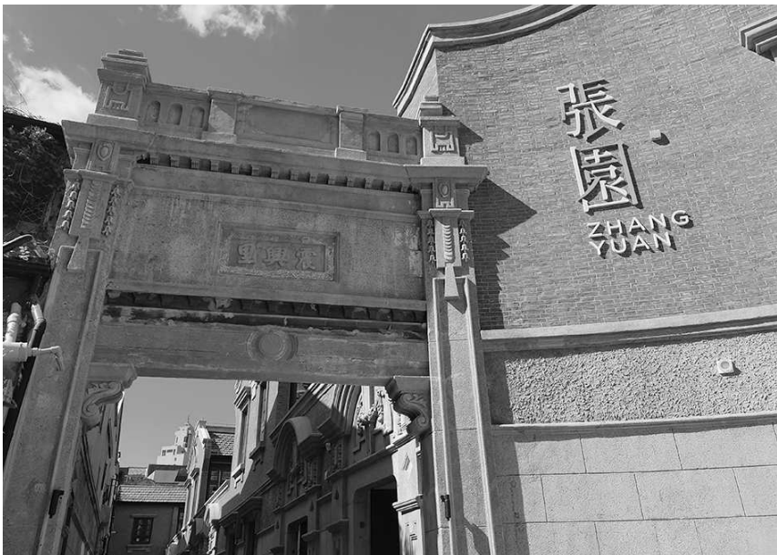
张园西区 17 幢历史建筑的修缮基本完成即将开门迎客
