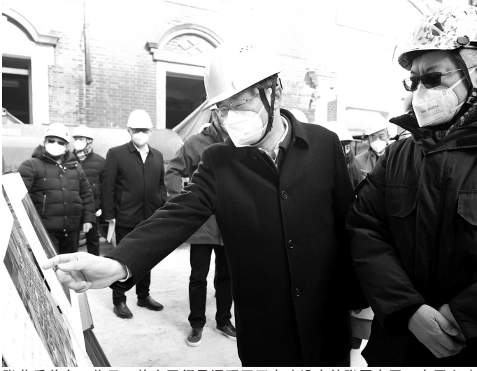
张节后首个工作日，静安区领导调研了正在建设中的张园东区，东区老建筑平移工程开年将持续推进通讯员 肖鸣亮 摄
