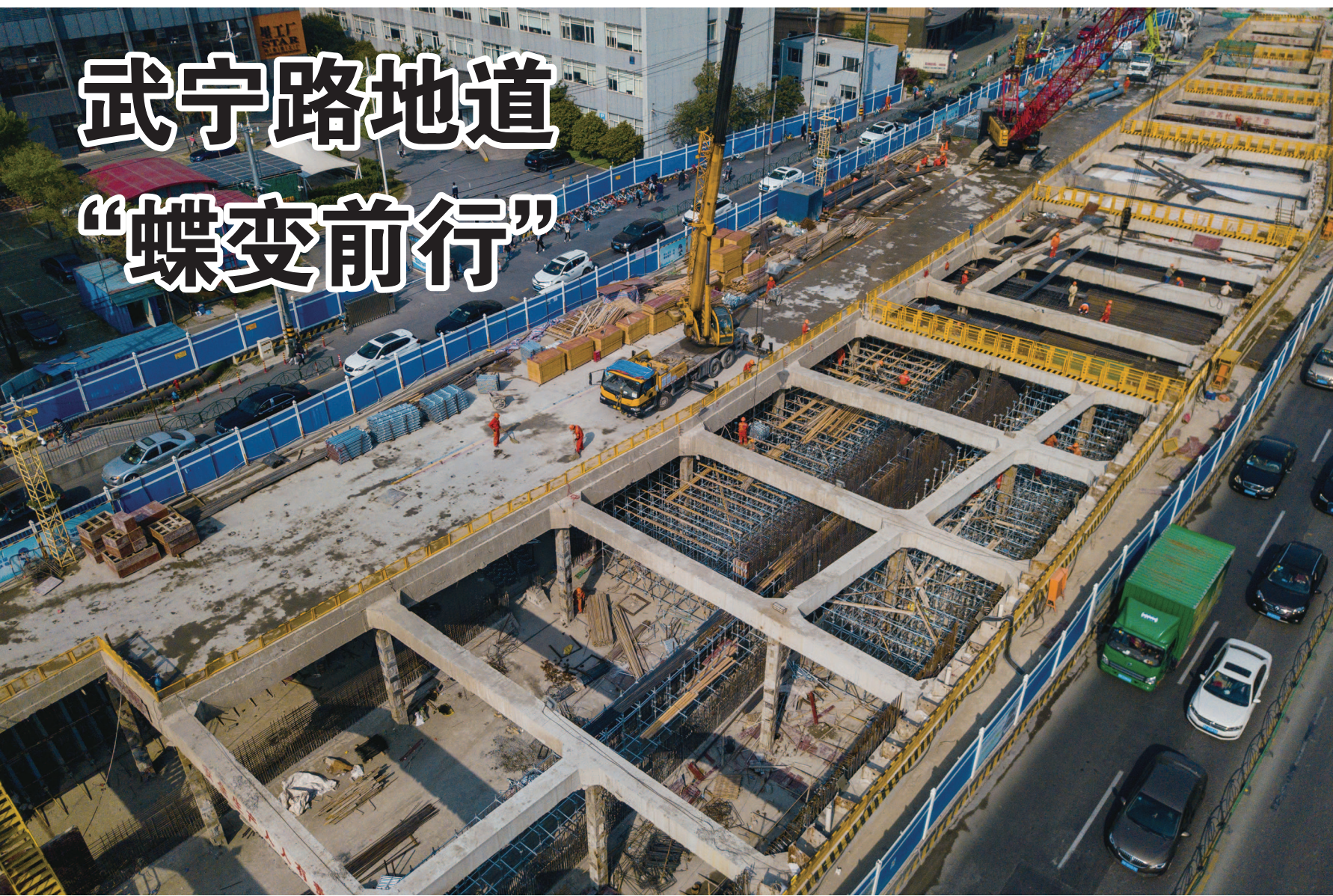
2019 年 4 月 8 日，武宁路 2 标施工中场面
