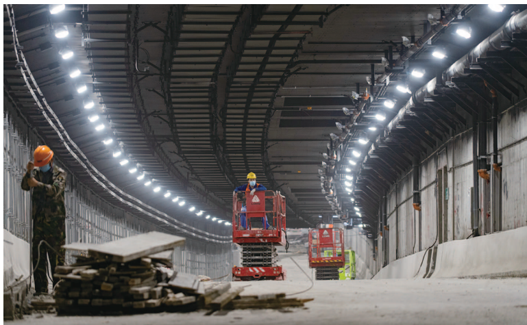
2022 年 10 月 23 日，武宁路机电安装
