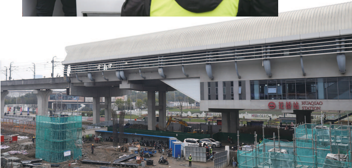
在建中的花桥站换乘通道
