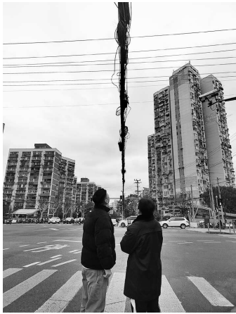
▲整治前,架空线缆密集杂乱,集成多捆黑色线柱和冗余盘留线圈
