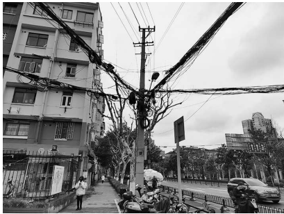
▲整治前,架空线缆密集杂乱,集成多捆黑色线柱和冗余盘留线圈
