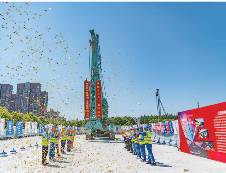
13 号线东延伸工程开工现场
