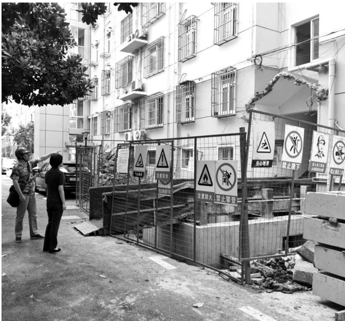
值班法官和居委会主任实地走访小区加装电梯施工现场
