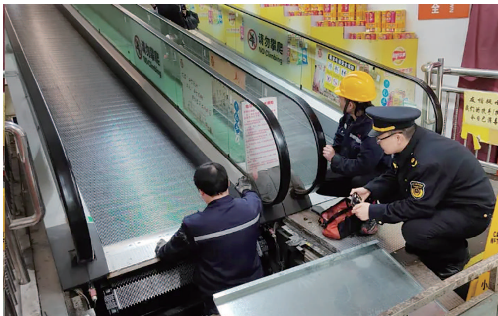
黄浦区市场监管局执法人员现场检查自动人行道踏板紧固情况
