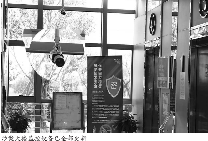
涉案大楼监控设备已全部更新
