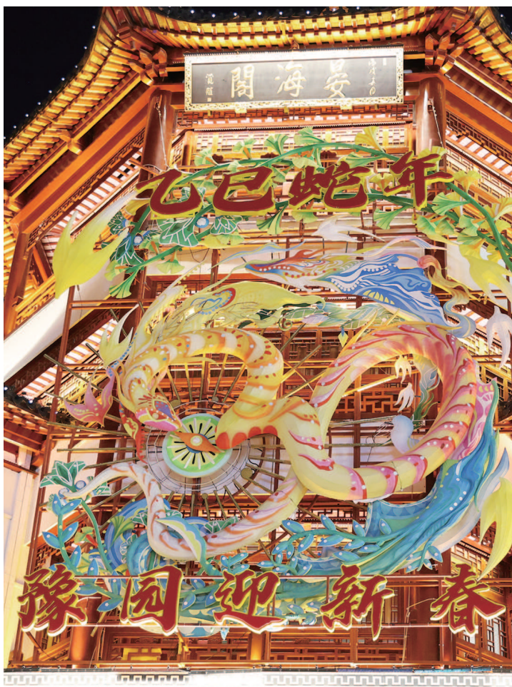
蛇形灯景装置被安装在晏海阁门头
