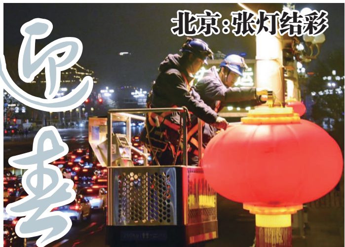
春节即将来临，国网北京市电力公司的城市照明管理中心开始在北京长安街等城市主干道两侧安装大红灯笼、中国结等，喜迎春节。图为国网北京电力城市照明管理中心的技术人员在调试北京长安街上的大红灯笼
